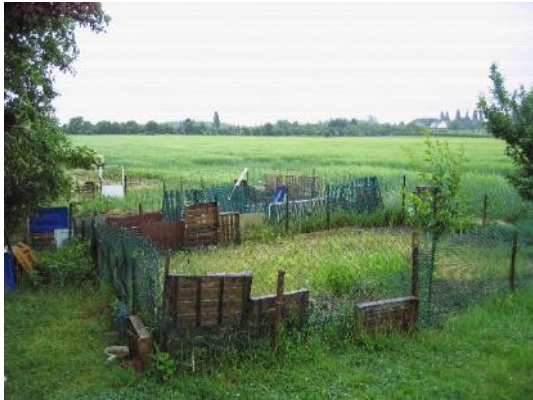
Pose de clôtures
