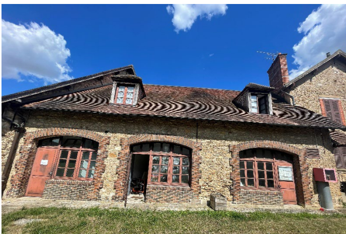
Photo 7 : Corps de ferme (locaux techniques)
