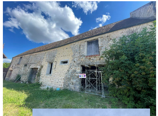
Photo 6 : Corps de ferme (anciennes écuries)
