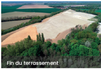
Fin du terrassement
