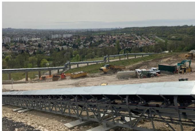
Mise en place d'une bande convoyeuse transportant les déblais du puits de creusement du tunnelier de la ligne 16, située à moins d'1 km du site
